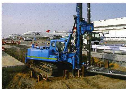
大型工事も安心施工
