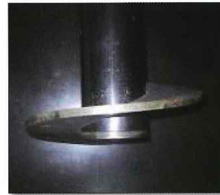
くい本体(鋼管)に取付
