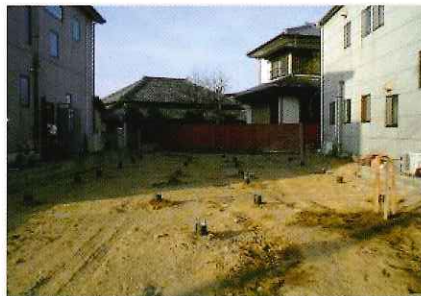
くい打設後もきれいな現場
